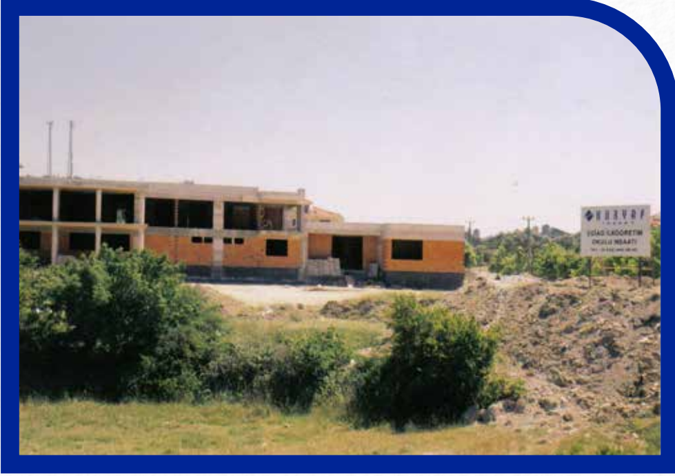
EGİAD İlköğretim Okulu İnşaatı
