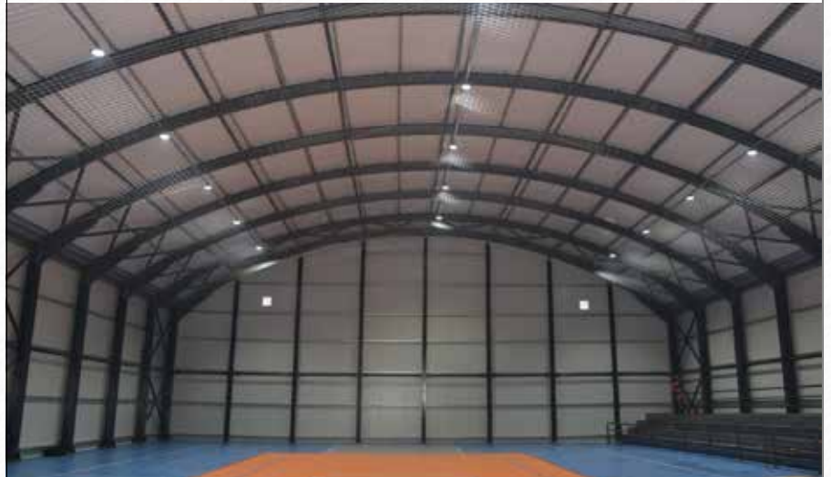
EGİAD Ortaokulu Spor Salonu Genel Görünüm
